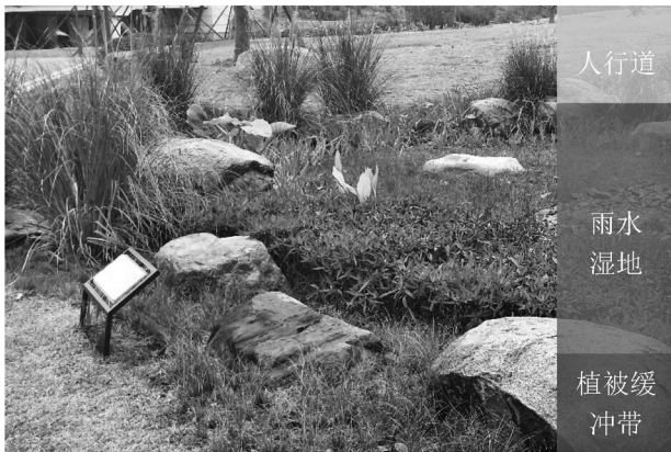
图 5 厦门市翔安新区路侧绿带海绵化
